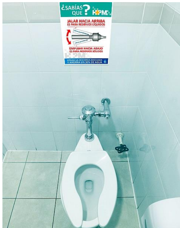
Servicios Higiénicos eficientes Hospital de puerto Montt
